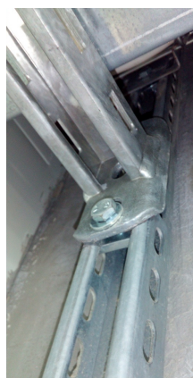
wspornik zamocowany do ceownika
