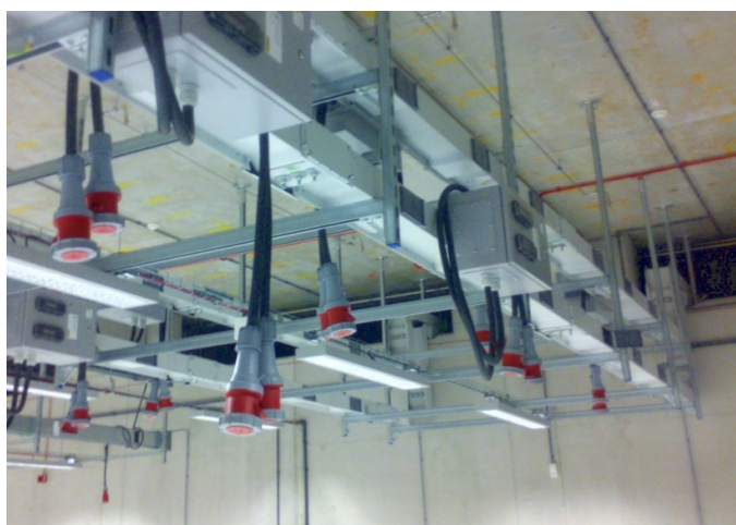
szynoprzewody z kasetami dystrybucyjnymi powieszono na konstrukcji z ceowników montażowych
