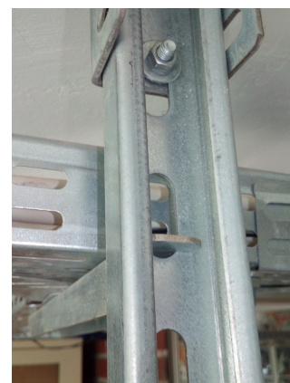
wykorzystanie perforacji ceownika do montażu
